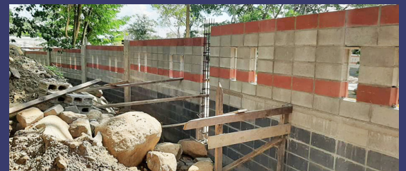
El muro tiene 1,738 metros de longitud.
