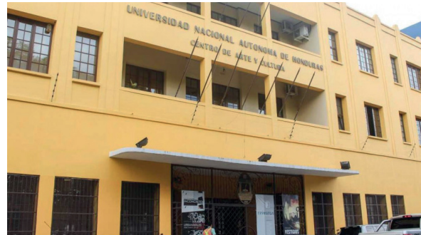
Fachada del CAC-UNAH, situado en Comayagüela.
